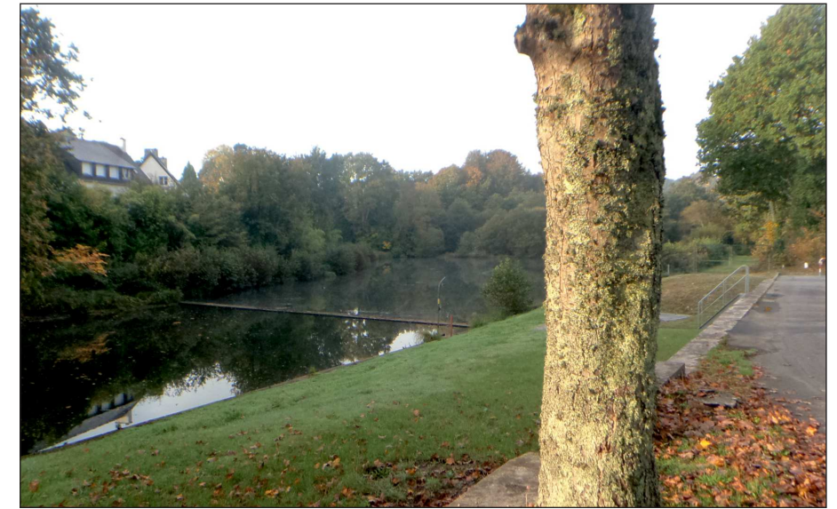
Photographie 2 : Vue des deux bassins depuis la station de potabilisation
