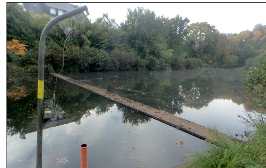
Photographie 7 : Vue du bassin amont depuis l'usine de potabilisation
