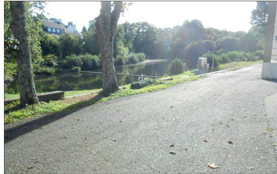
Photographie 1 : Vue des deux bassins depuis la station de potabilisation
