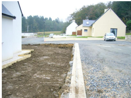
Terrassement en déblais détériorant la structure des chaussées
