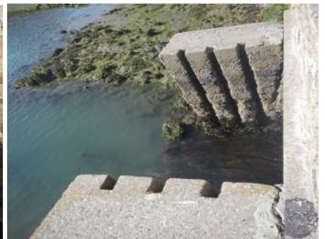
Vue amont du canal de fuite
