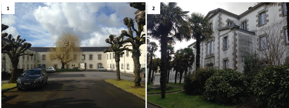
Bâtiment Direction administrative à réhabiliter
