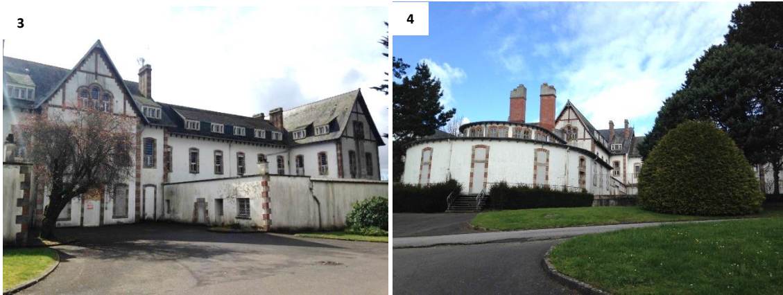
Bâtiment principal à réhabiliter
