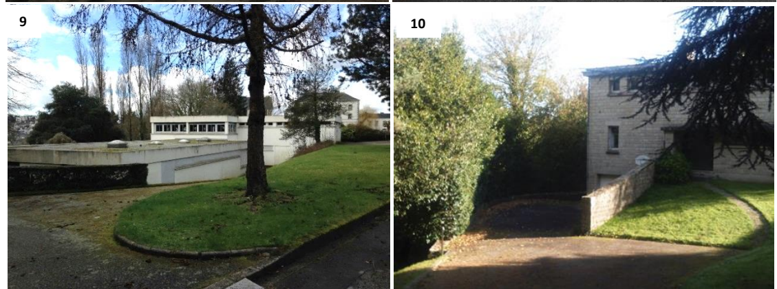
Bâtiments à démolir
