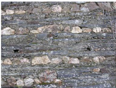
Maçonnerie de schiste avec insertion de blocs de quartz (lieu dit de Villeneuve La Brousse)
