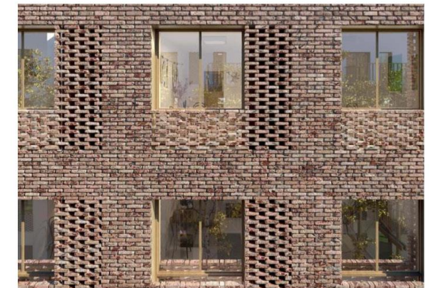
Résidence étudiante, Pierrefitte, BFV architectes, parement en brique de réemploi
