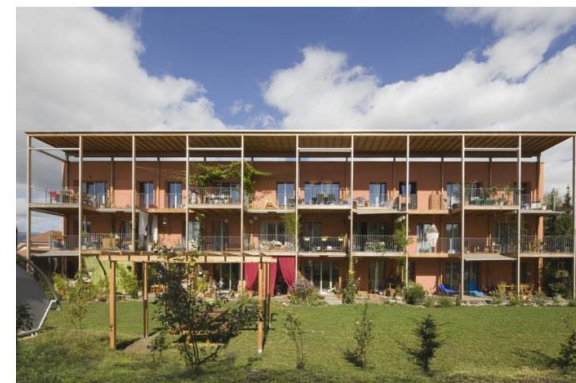
Façade différenciée, protections solaires par balcons autoportants, ATBA architecture, Genève
