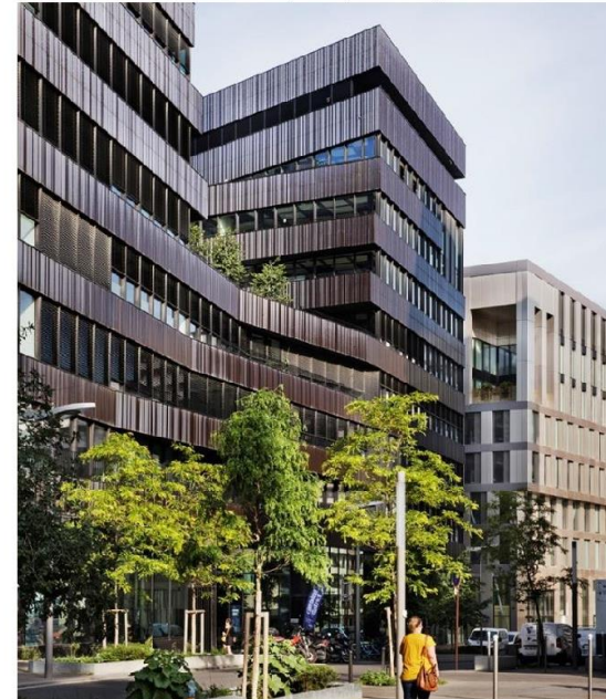
Immeuble de bureaux, Clichy Batignolles, Enjeu d'écriture architecturale pour les bureaux : brise-soleils robustes et intégrés à la façade, façades épaisses, taux de vitrage mesuré,
