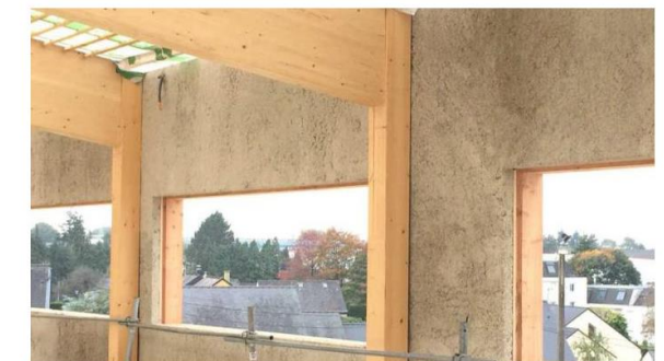
Façades en panneaux préfabriqués de béton de chanvre, CAN Ingénierie Architecture
