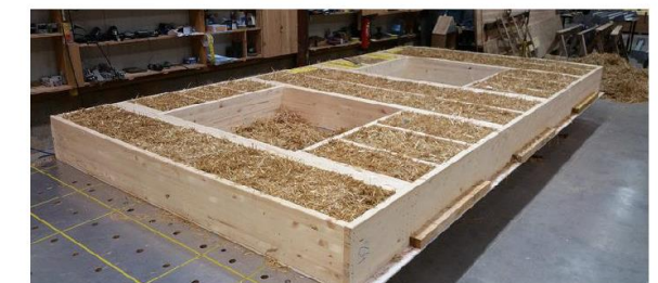
Isolation en bottes de paille, NZI architectes
