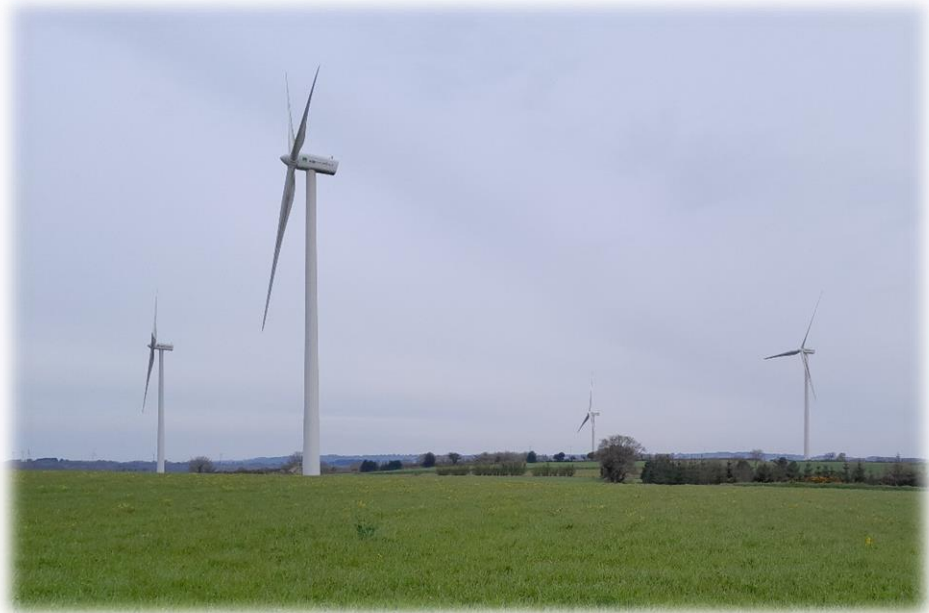
Vue du parc éolien de Bourbriac (G. Le Guen, TBM environnement)
