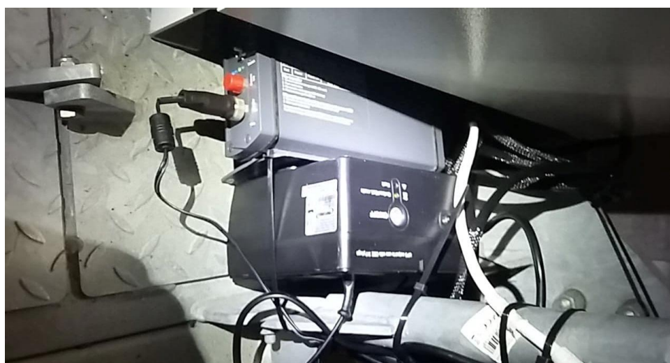
Photo 1 : Détecteur et micro installés dans la nacelle de l'éolienne E2
