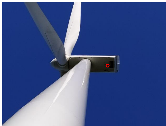
Figure 7 : Enregistreur placé en nacelle (source : Synergis Environnement)
