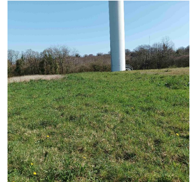
Photo 3 : Environnement de l'éolienne E2
