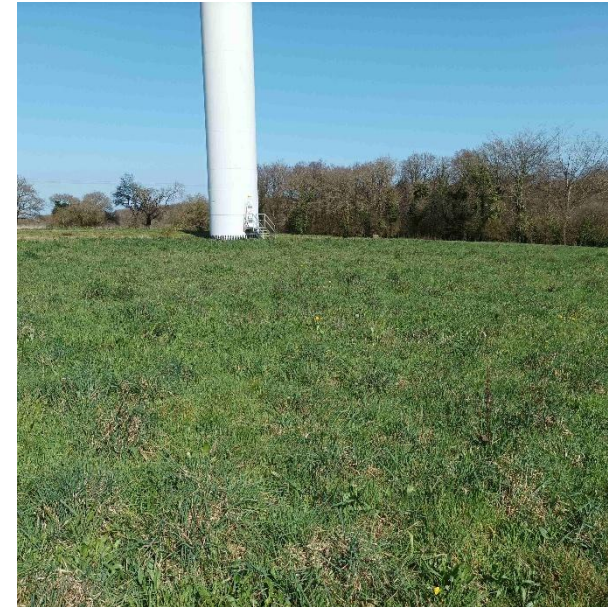
Photo 2 : Environnement de l'éolienne E1
