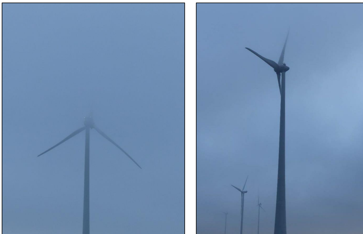
Photo 1 : Exemple de situation à risque : brouillard en hauteur masquant tout ou partie des pales.
