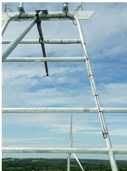
Photo 9: Micro sur bras déporté en pvc permettant l'inclinaison du micro vers le bas – Source Engie Green
