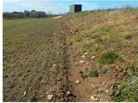
Décrochement de terrain en limite des cultures et de l'aire de travaux
