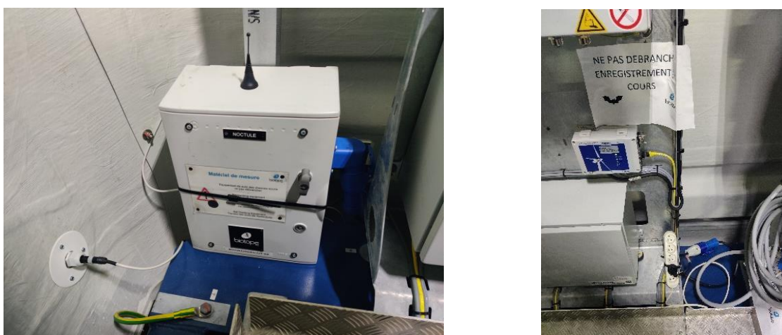
Figure 11 : Illustrations du dispositif d'écoute en nacelle et du positionnement micro en nacelle.
