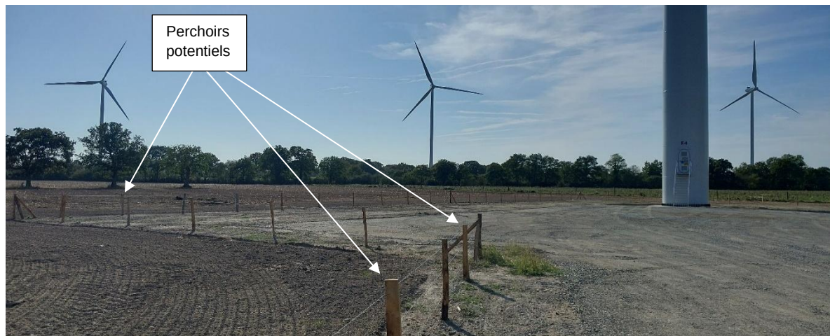
Figure 71 - Photographie des perchoirs potentiels pour l'avifaune à éviter (photographie prise hors site)
