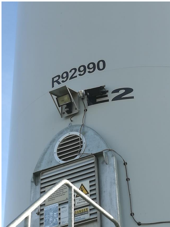
Figure 7 : Photos d'une caméra infrarouge et de son illuminateur fixés sur le mât par des aimants
