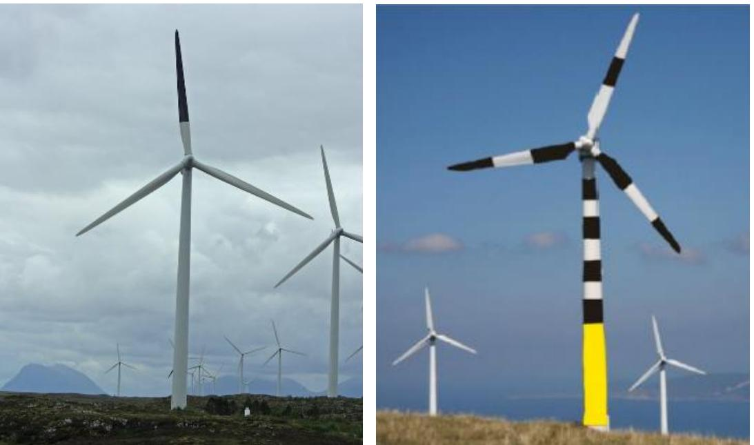
Figure 24 : Différentes méthodes de mise en évidence des éoliennes pour augmenter leur visibilité par les oiseaux
