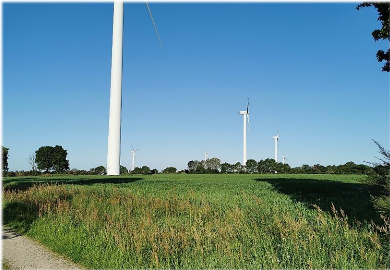
Vue du parc éolien de Gueltas – TBM environnement
