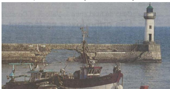
Le Palais, Février 1996 (Ouest France)
