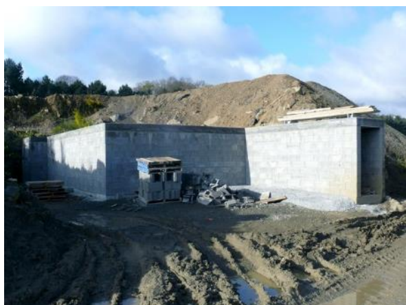
Souterrain créé de toute pièce pour les chauves-souris dans une carrière, avant et après recouvrement.
