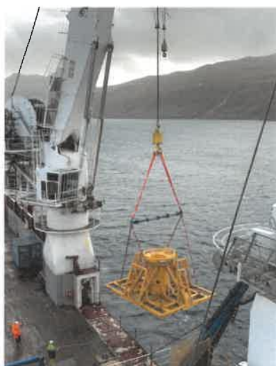
Figure 8 - Installation de la fondation
