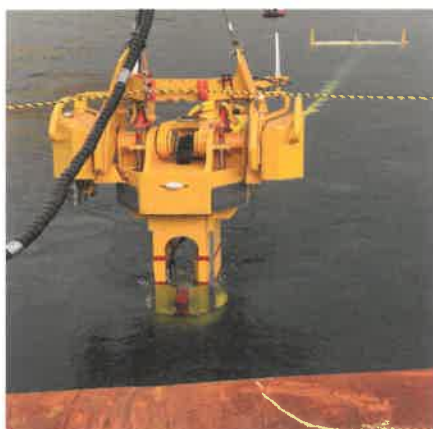
Figure 12 - Abaissement du connecteur d'attache
