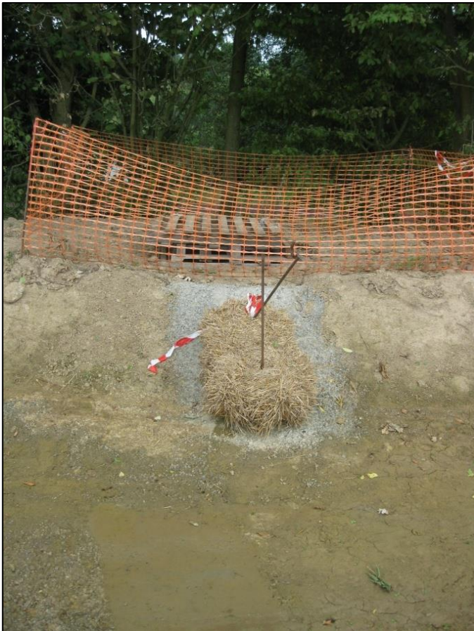
Photo 5 : Emplacement du filtre à particules fines (botte de paille) pendant la phase des travaux au niveau d'un bassin de rétention
