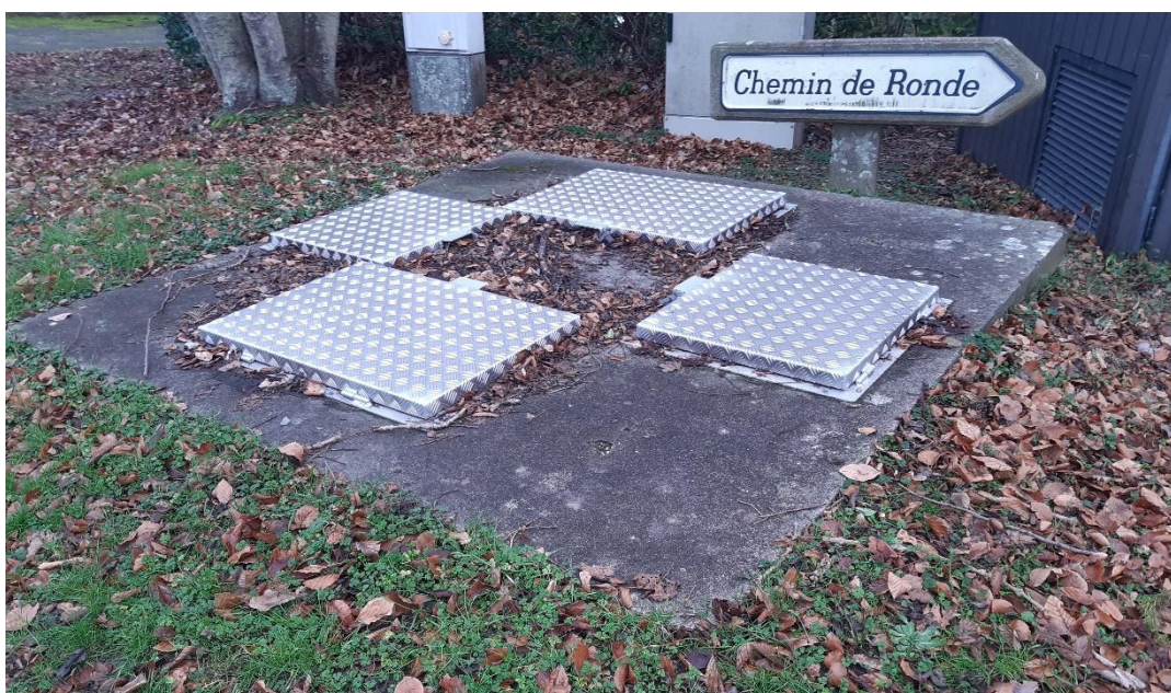
Figure 7 Exemple de trappes d'accès visible au niveau d'un poste de relevage
