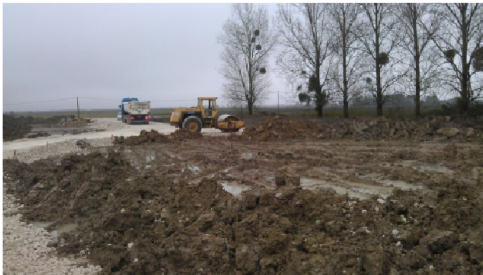
Mise en œuvre de la voirie d'accès pour le chantier
