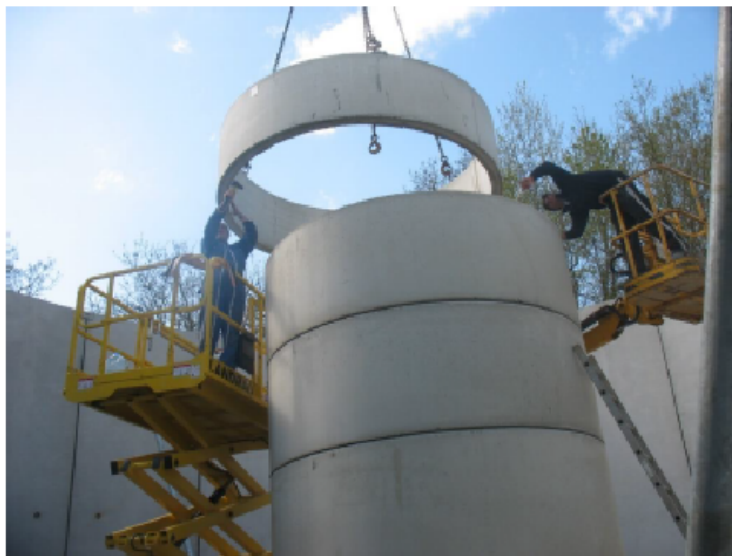
Assemblage des éléments industrialisés
