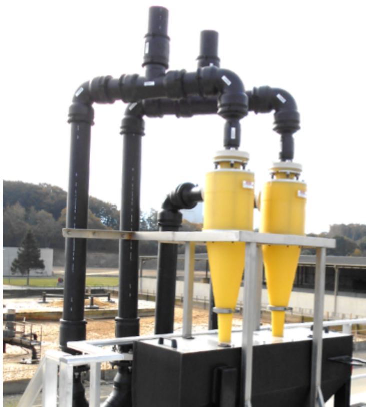
Exemple d'installation d'hydrocyclone (Cideral 22)
