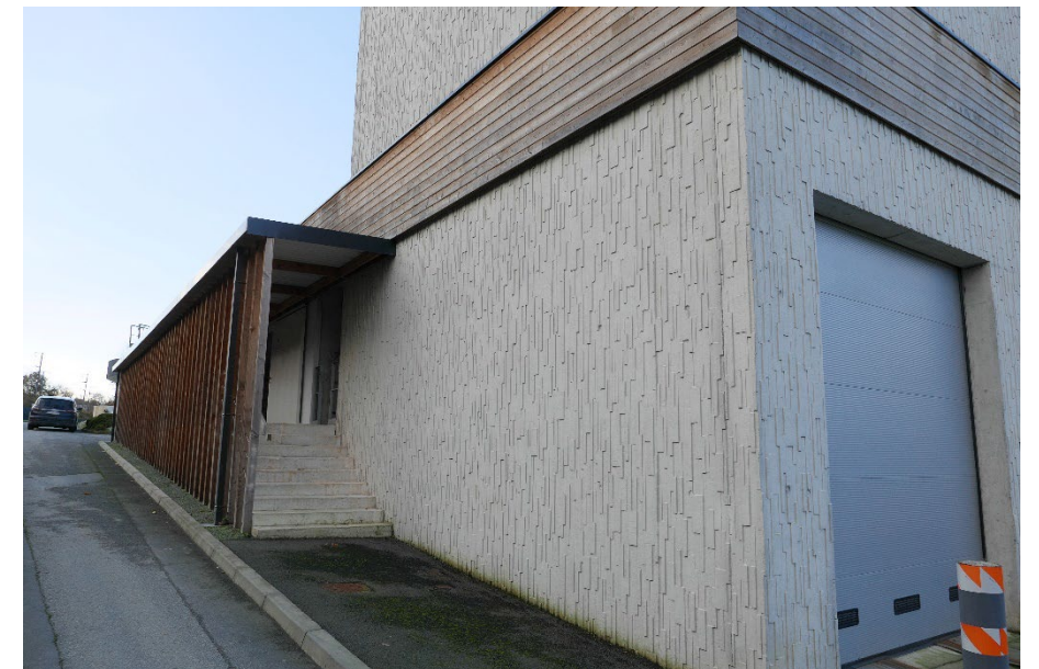
Béton matricé et bardage bois – Mathieu Barré pour la STEP de Grâces (22)
