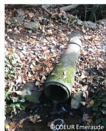
Figure 2.7: Buse traversant le chemin à l'extrémité sud du site de la Vallée de la Fosse/Pont Briand.
