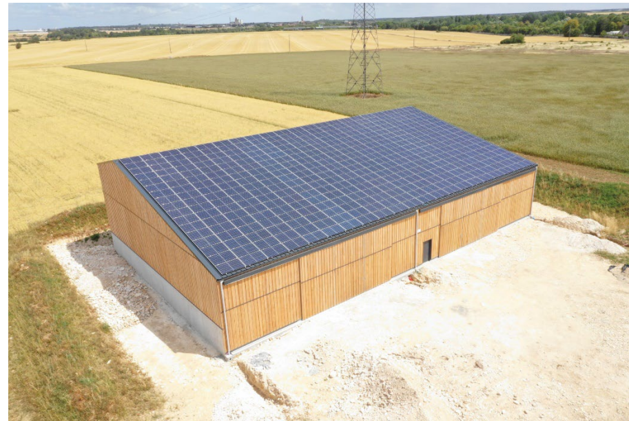
Panneaux photovoltaïques intégrés sur toiture bac acier – Hangar agricole (crédit photo Groupe Roy Energie)
