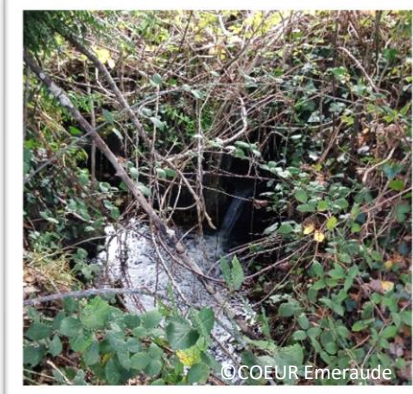
Figure 2.6: Buse située sous le chemin d'entrée de la propriété de N. Salet et créant une chute de plus de 40cm de hauteur.
