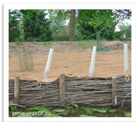
Figure 2.10: Fascinage d'une berge.
