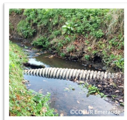
Figure 2.4: Buse plastique constituant un seuil à l'aval du site de la Vallée de la Fosse/Pont Briand.
