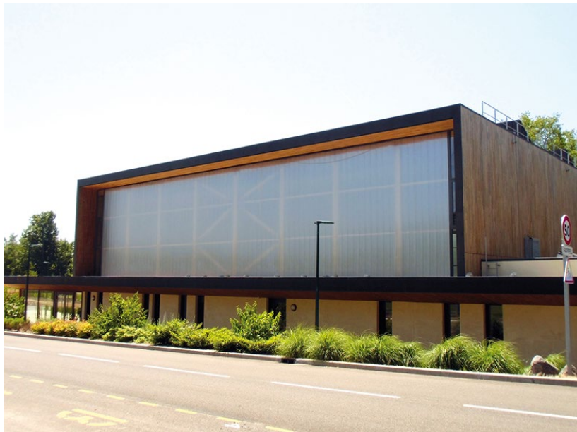
Bardage bois et polycarbonate – Cabinet Hubert pour le gymnase d'Aurus (40)
