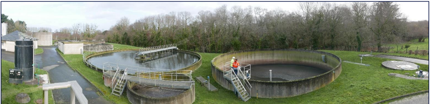
Figure 15 : Vue du clarificateur et des ouvrages annexes, ainsi que du bassin tampon
