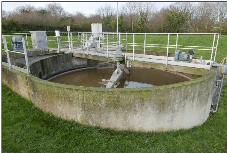
Figure 13 : Dessableur dégraisseur
