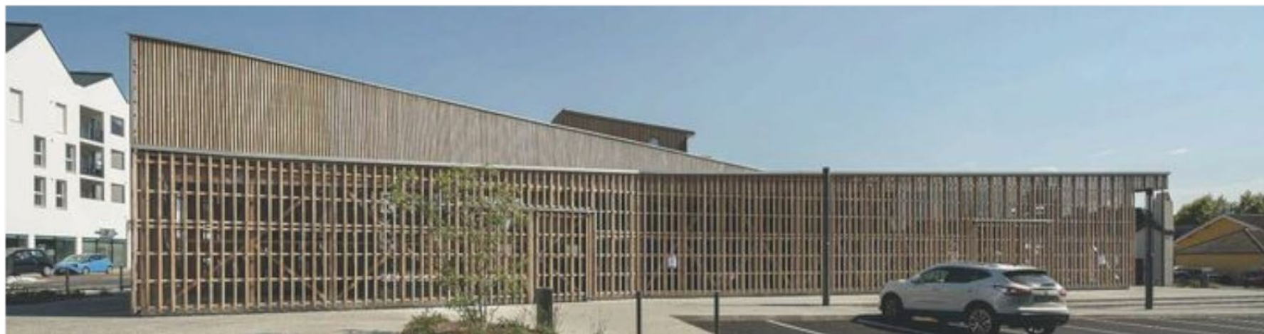
Bardage bois ajouré et polycarbonate ondulé – Pierre Marsan pour les halles de Billère en 2020 (64)
