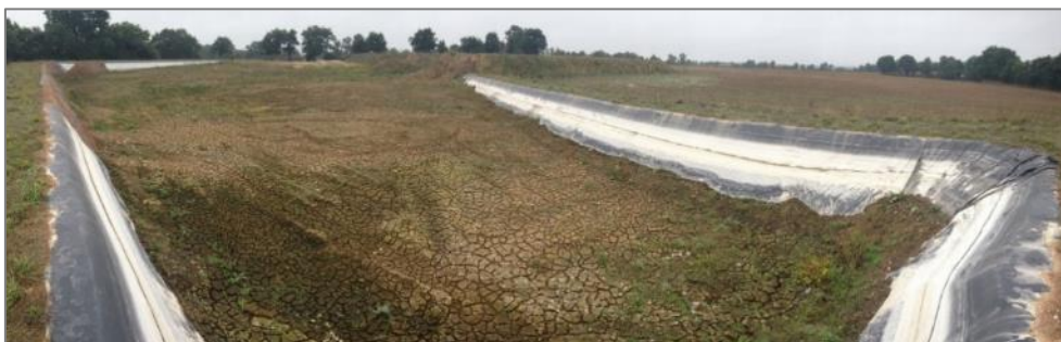
Figure 7 : Exemple d'un casier de ressuyage avec géomembrane (IDRA)
