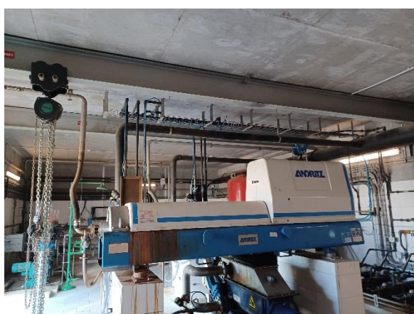
Centrifugeuse (file 1)
